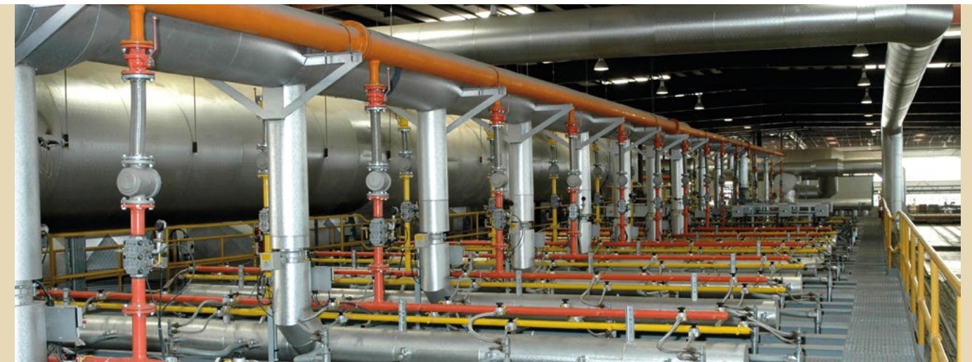
Dualbrennanlage für Biogas und Erdgas Dual fuel firing system for landfill gas and natural gas
